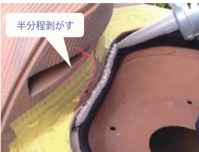
パン背面部のエプトシーラーにコーキング材をのせます。その後溝の下のマスキングテープを半分程剥がしておきます。※パン取付後、マスキングを剥がしやすくなります。
